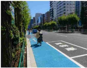
普通自転車専用通行帯 (自転車レーン) 白山通り(文京区)
