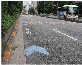
車道混在 (自転車ナビマーク・ 自転車ナビライン) 鍛冶橋通り(中央区)
