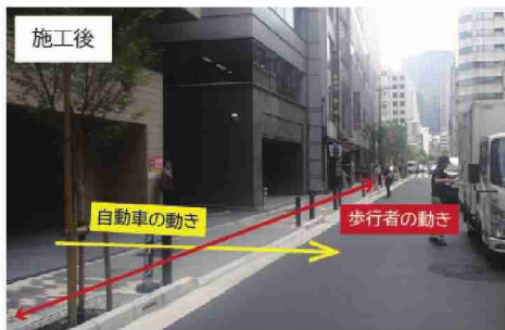
セミフラット方式の歩道
