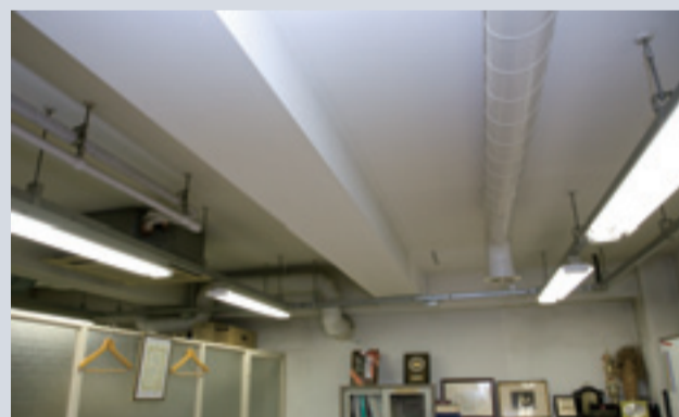
会議室など光量を落とせるところから蛍光灯を省エネしていきます。
