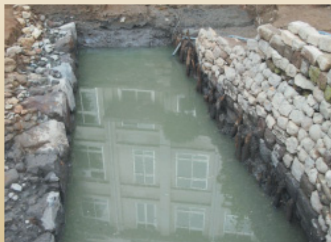
江戸期の掘割「越前堀」 左岸が武家地 右岸の町家の石組に比べて大きい石が使われます
