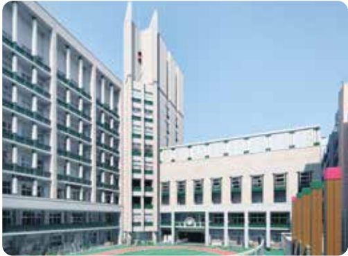
日本橋小 外観
