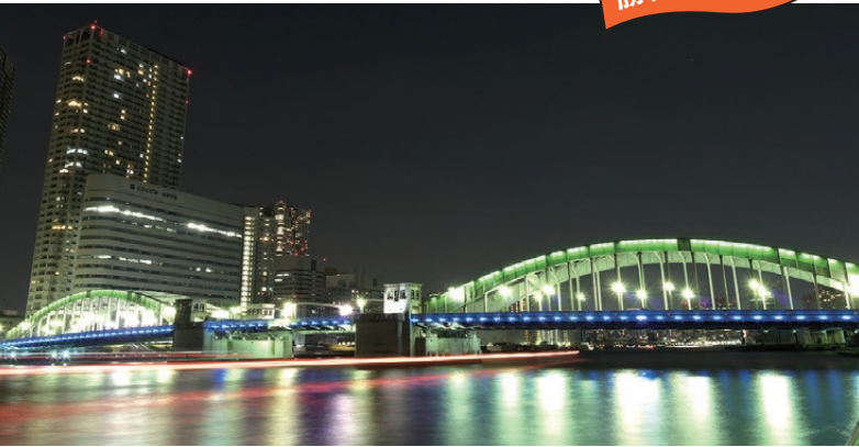
橋の両端はアーチ橋、中央は上部に開く跳開橋ですが、今は開くことはありません。
