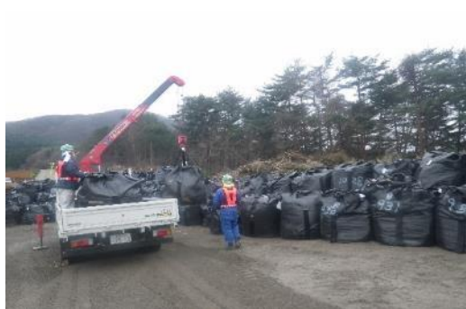
仮置場への搬入の様子
