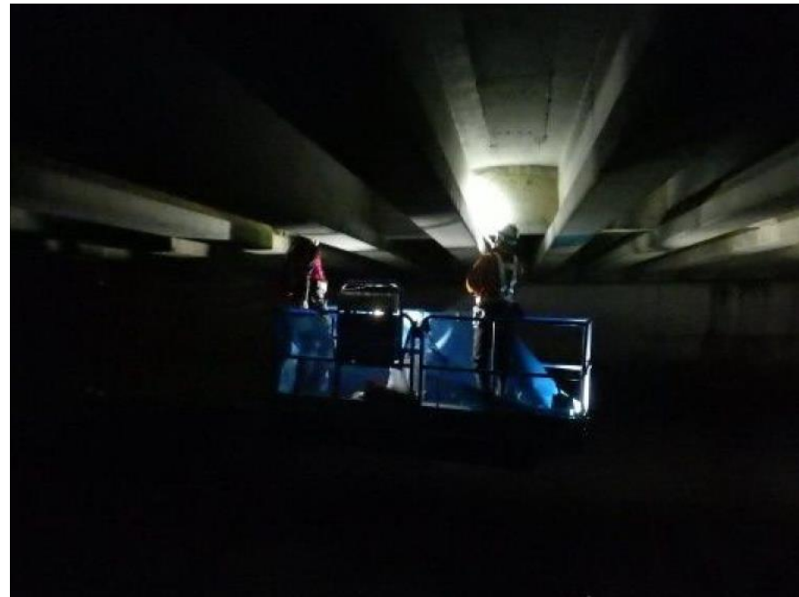
▲中里新橋損傷調査状況(夜間)
