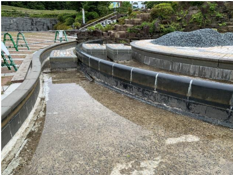
▲噴水池防水改修
