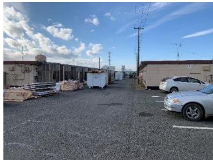
▼ 解体中の仮設住宅
