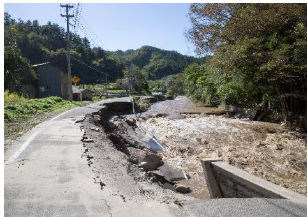
片側の車線が隣を流れる川に 流された様子（令和元年10月）
