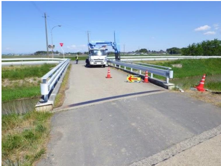
▲見留田橋損傷調査状況
