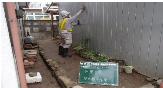
宅地除染の様子
