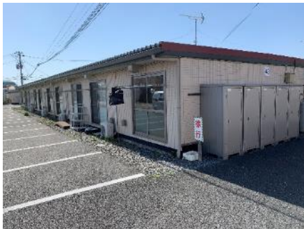
▼ 解体前の仮設住宅
