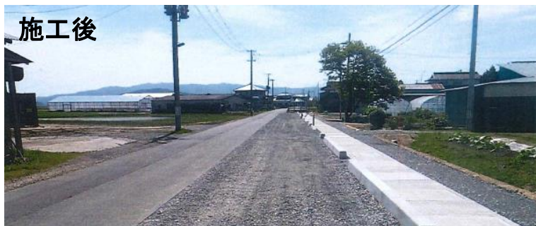
▲施工前 施工後の状況
