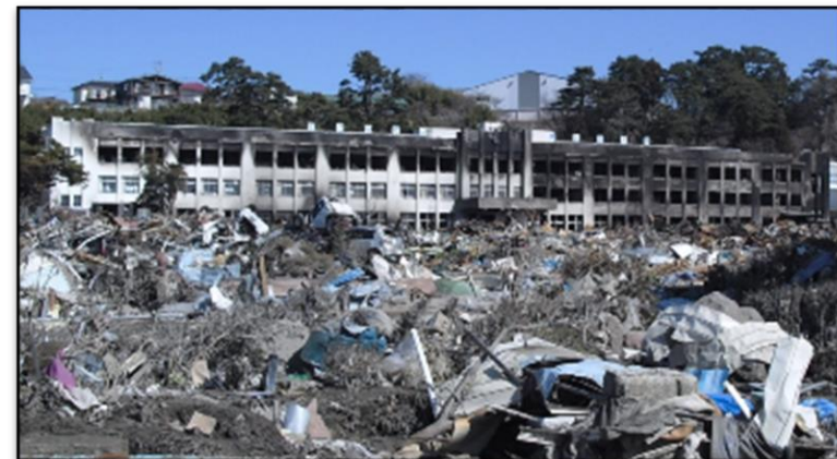
▲津波火災を受けた門脇小学校 (平成23年3月)
