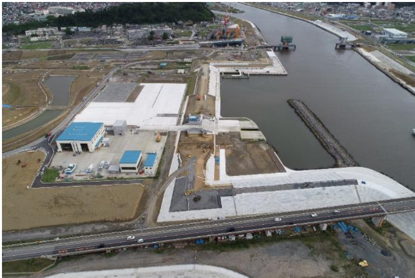
▲着手前整備状況（令和2年9月時点）
