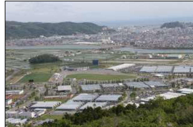
▲ 仮設住宅団地(開成地区)
