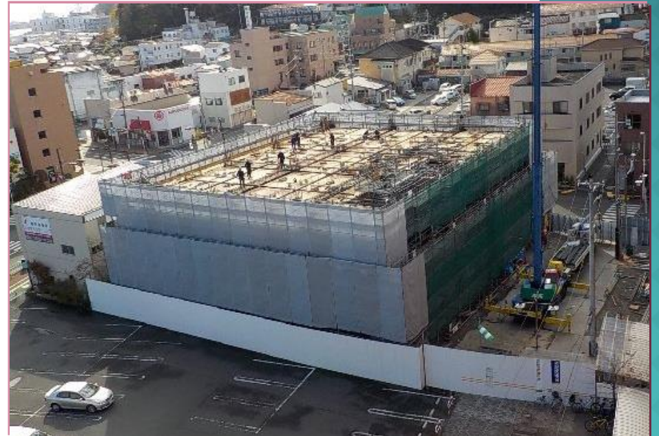
建設状況（H29.11末時点）
