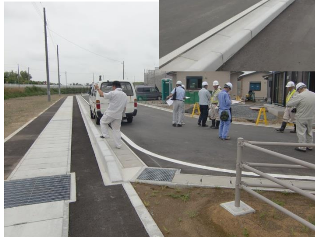
「防災集団移転促進事業」完成検査風景
