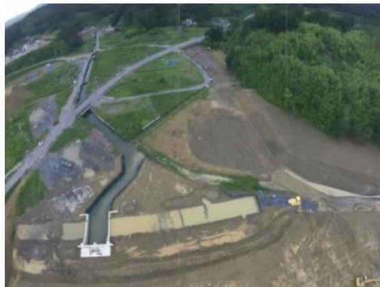
左：離島（金華山）現場写真 右：ドローン撮影画像
