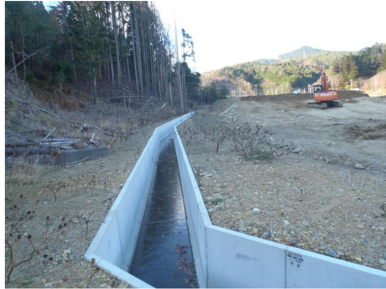
復旧後（平成27年12月時点）
