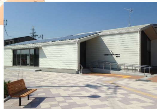
(石巻市内の復興公営 住宅及び集会所)
