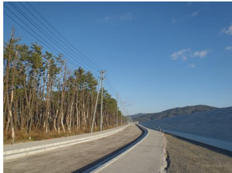
工事中（平成27年12月時点）
