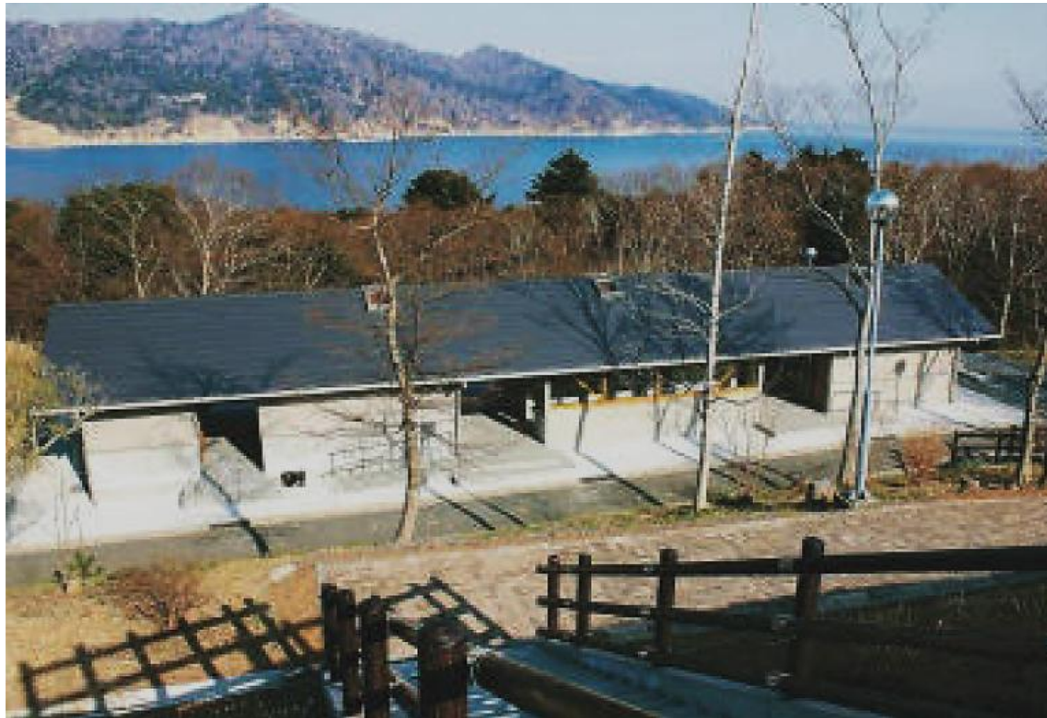
サニタリー棟 完成写真
