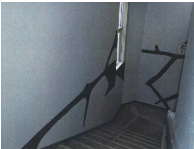
牡鹿総合支所 改修状況
