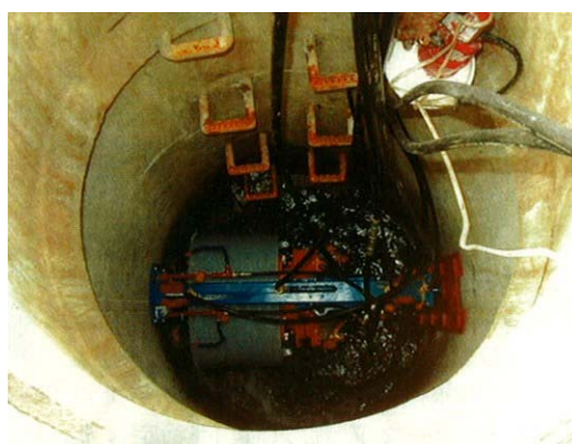
マンホール内での耐震工事
