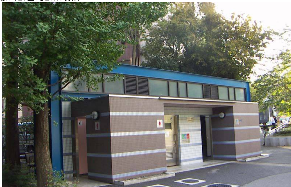
桜川公園内公衆便所
